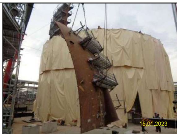
ข) กิจกรรมการติดตั้งถังเก็บพักโพเทน/แอลพีจีเพิ่มเติม จำนวน 2 ถัง
