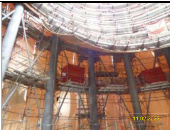
ข) กิจกรรมการติดตั้งถังเก็บพักโพรงไฟ/แอลพีจีเพิ่มเติม จำนวน 2 ถัง
