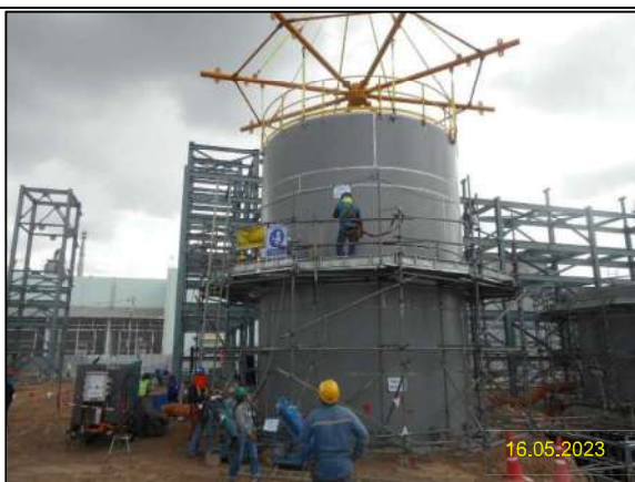
ข) กิจกรรมการติดตั้งหน่วยกำจัดกลิ่นแบบอาร์ทีโอ (Regenerative Thermal Oxidizer; RTO) และ SO 2 Scrubber
