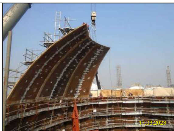
ข) กิจกรรมการติดตั้งถังเก็บพักไพรเพน/แอลพีจีเพิ่มเติม จำนวน 2 ถัง
