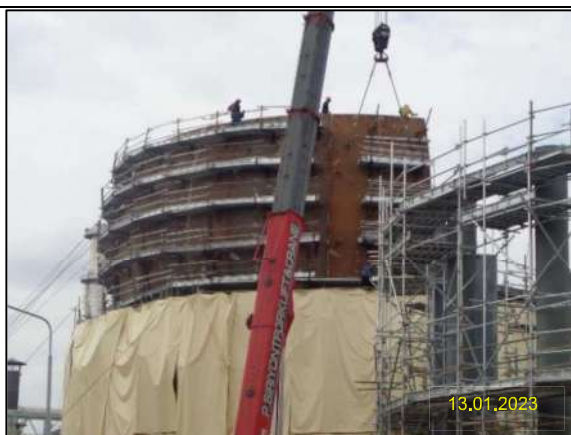
ข) กิจกรรมการติดตั้งถังเก็บพักโพเทน/แอลพีจีเพิ่มเติม จำนวน 2 ถัง
