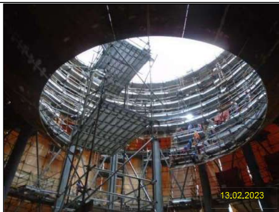
ข) กิจกรรมการติดตั้งถังเก็บพักโพรงไฟ/แอลพีจีเพิ่มเติม จำนวน 2 ถัง
