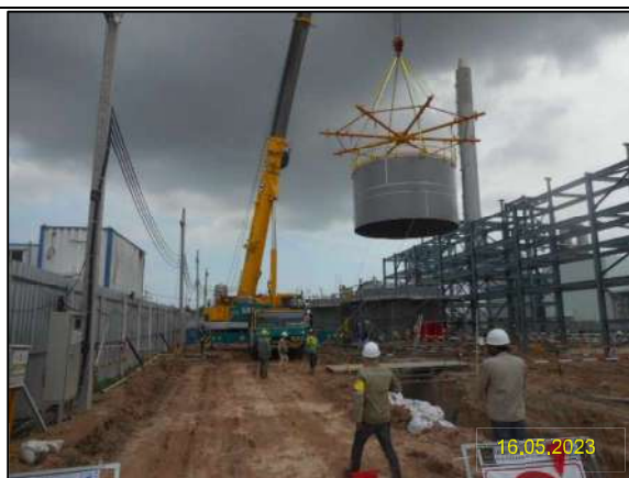
ข) กิจกรรมการติดตั้งหน่วยกำจัดกลิ่นแบบอาร์ทีโอ (Regenerative Thermal Oxidizer; RTO) และ SO 2 Scrubber
